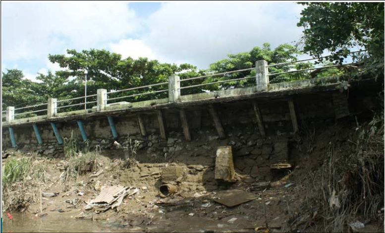
ပြိုမကျစေရန် ဒေါက်နဲ့ကန်ထားသော မြင်ကွင်းပုံ (ဆ-၂)
