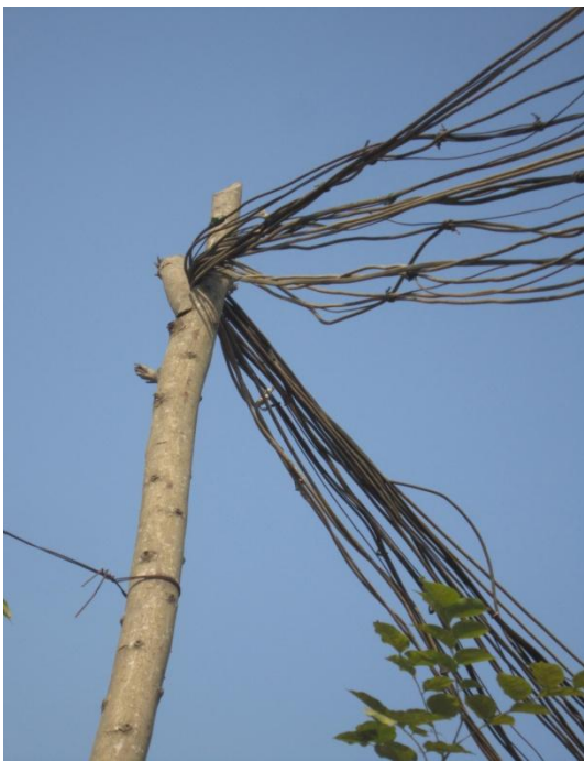
တိုင်ထိပ်ခွကြား မီးကြိုးများဖြင့် သွယ်တန်းထားပုံ (ယ-၁)
