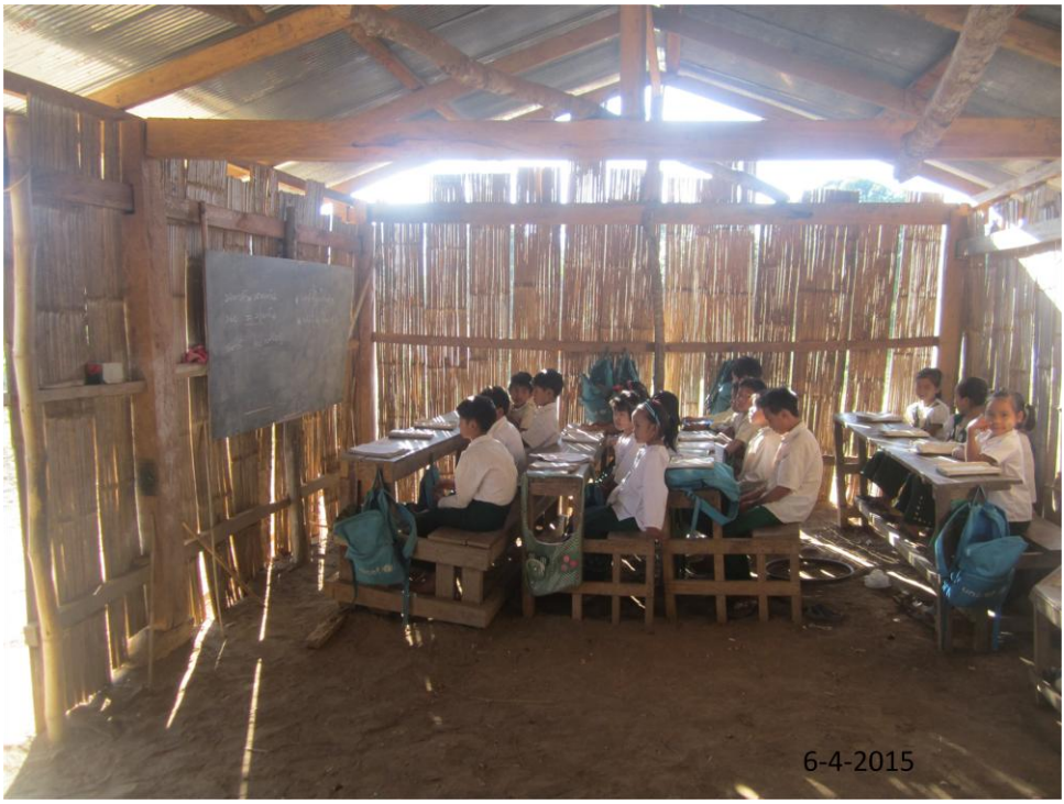
မိုင်းကိုင်မြို့၊ အခြေခံပညာမူလတန်းကျောင်း ဝါး၊ ထရံကာ သွပ်မိုး အဆောက်အဦအတွင်း စာသင် ခန်းမပုံ (ခခ -၂)
