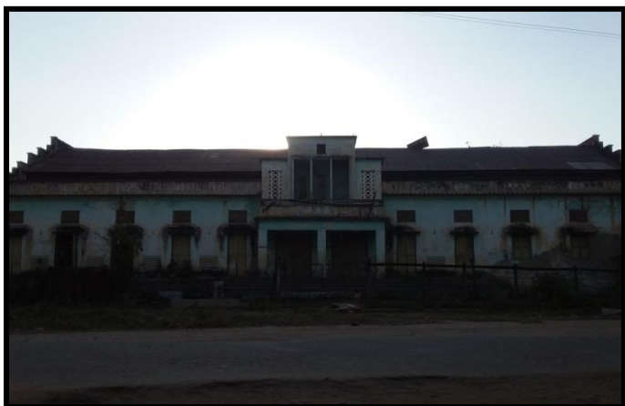
အန္တရာယ်ရှိ အဆောက်အအုံ လှည့်ရီ ရုပ်ရှင်ရုံဟောင်း မြင်ကွင်းပုံ (၀-၁)
